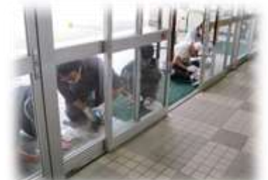
コーキング作業より
